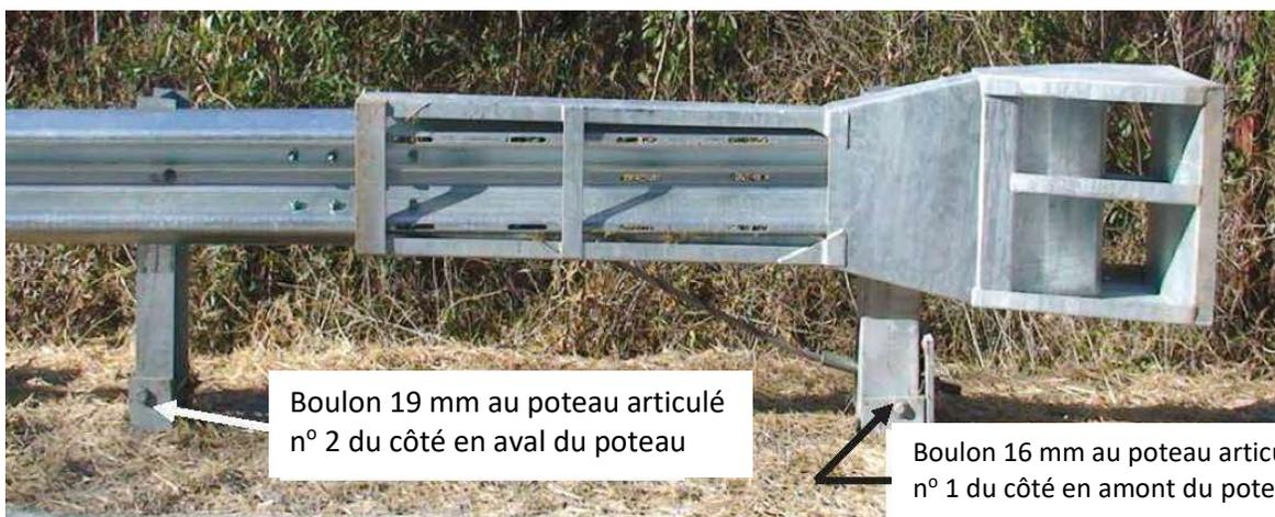
**Figure 6. Vue détaillée du raccordement du poteau n° 1 pour les systèmes SKT-SP et FLEAT-SP**
