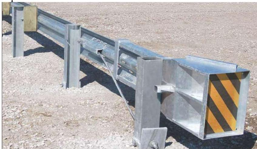
**Figure 5. Vue du poteau terminal n° 1 en acier du système FLEAT-SP**
